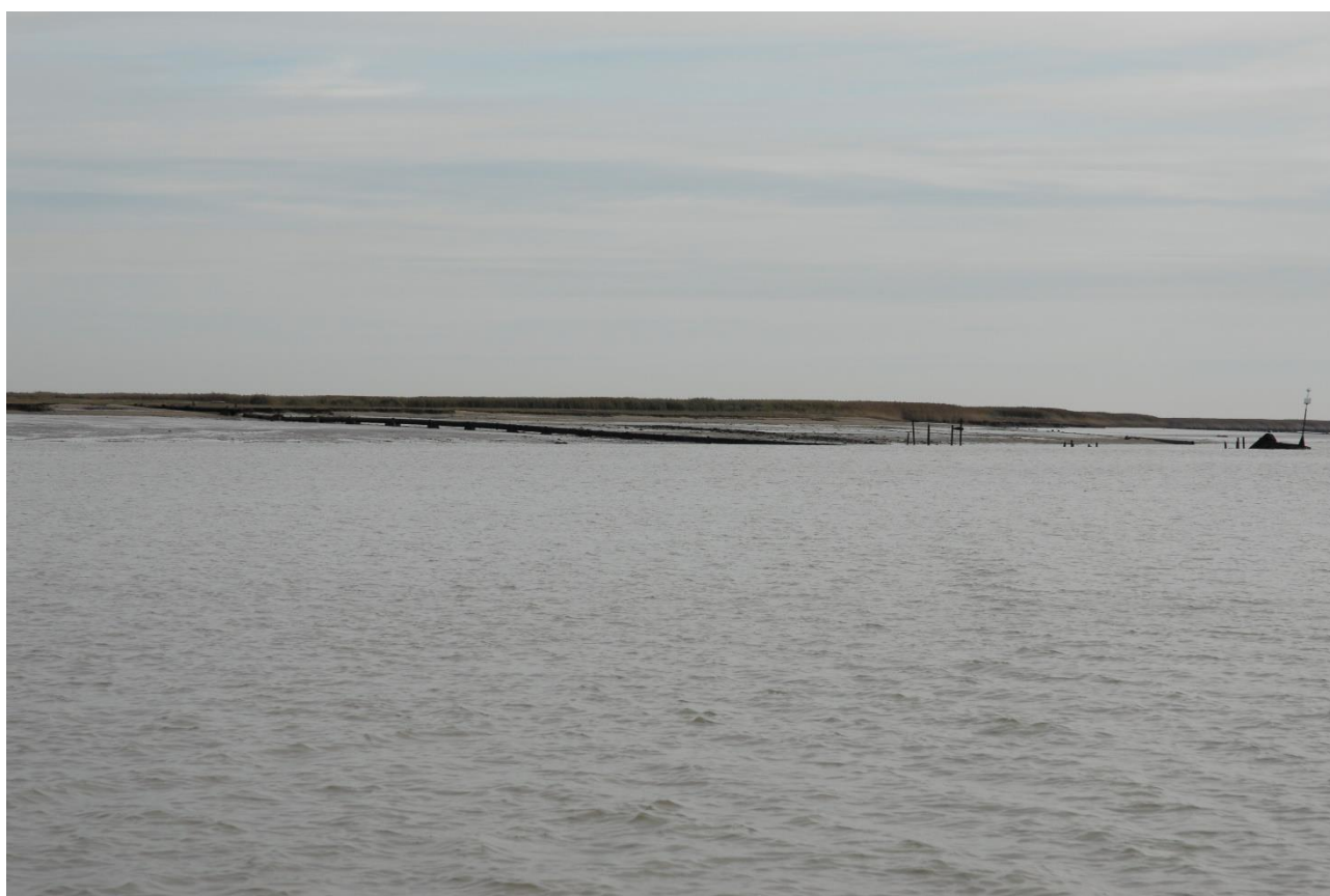
Ancienne canalisation de refoulement des sablo-vases du Port Autonome Nantes-Saint-Nazaire (aujourd'hui Grand Port Maritime Nantes/Saint-Nazaire), point de repère retenu comme limite des secteurs de Donges-Est et de la Tour aux moutons/Pierre Rouge (© F. FONTENEAU)
