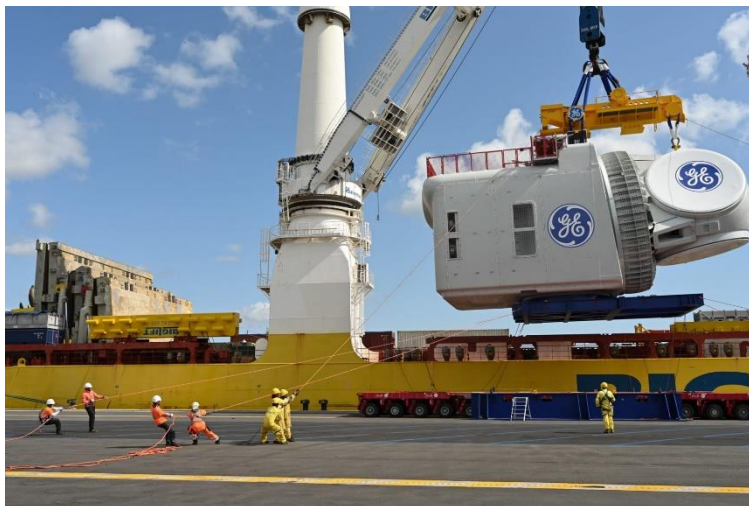
Figure 6 : Déchargement d'une turbine d'éolienne sur le quai préparé pour l'accueil des composants du parc éolien offshore de St Nazaire
