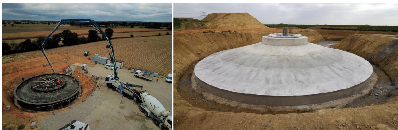
Photo 1 : fondation d'éolienne
