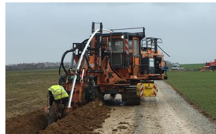
Photo 2 : mise en place du réseau électrique inter-éolien
