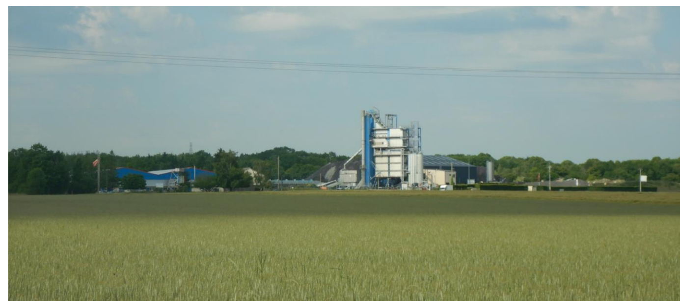
Photo 12 : centrale d'enrobage depuis le centre de la zone d'implantation potentielle
