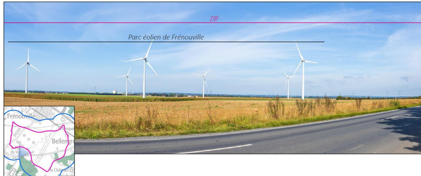
Photo 15 : Zone d'implantation potentielle des éoliennes (ZIP) et parc éolien de Frénoville depuis le croisement RD41/RD89
