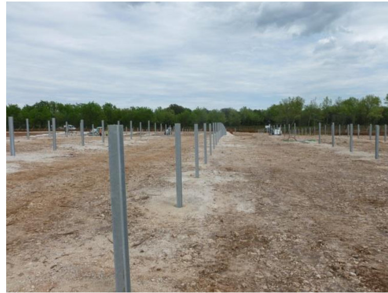
Illustration du chantier de création d'un parc photovoltaïque au sol avec pieux battus et bâtiments techniques
