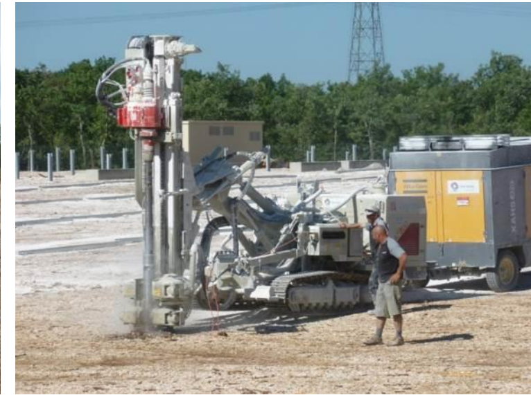
Illustration du chantier de création d'un parc photovoltaïque au sol avec pieux battus et bâtiments techniques
