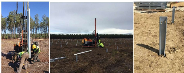
Figure 45 : Exemples de mise en place des pieux battus sur les chantiers URBASOLAR
