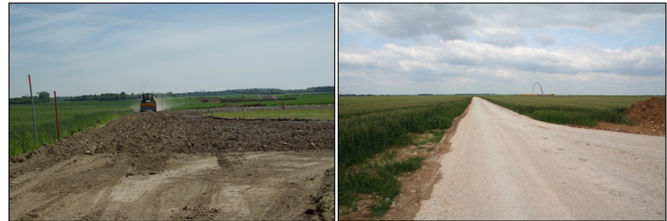
Figure 11 : Aménagement des accès
