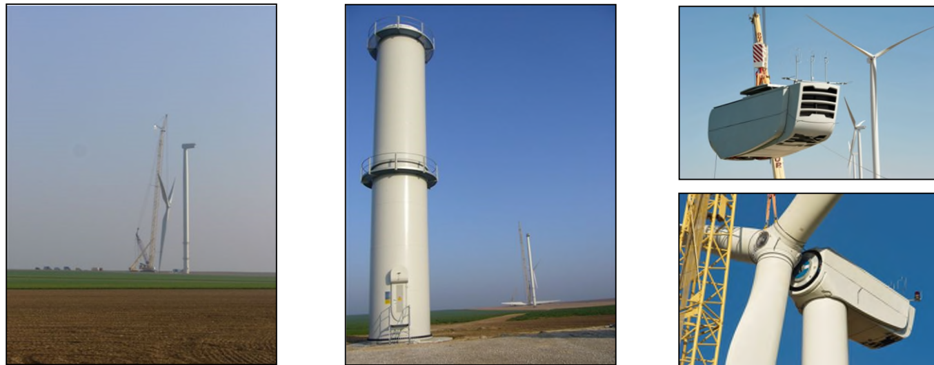
Figure 14 : Montage d'une éolienne
