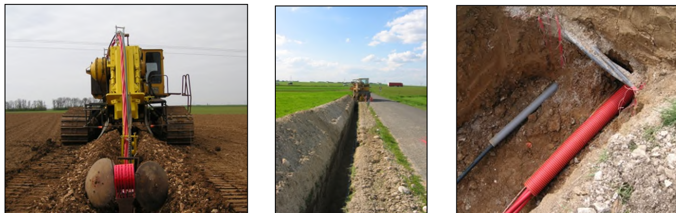
Figure 15 : Installation du raccordement électrique
