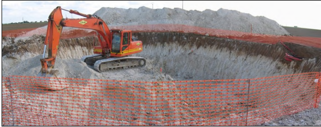
Figure 12 : Installation des fondations
