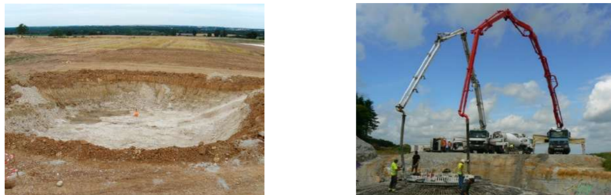
Figure 168 : Exemples de ferrailage et coulage des fondations
