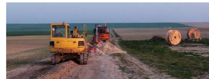
Figure 170 : Exemple de travaux pour l'installation du raccordement enterré
