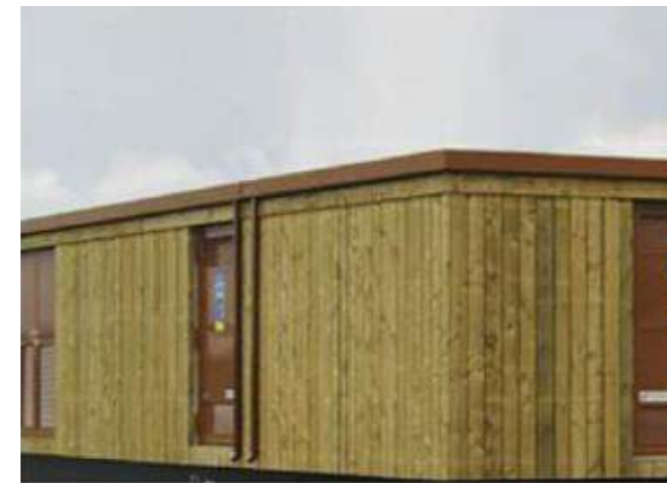
Figure 218 : Exemple de poste de livraison avec bardage vertical de bois naturel
