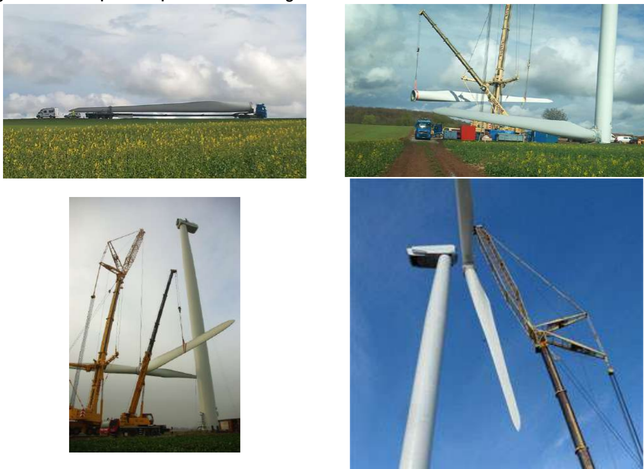
Figure 169 : Exemple de séquences d'assemblage d'une éolienne
