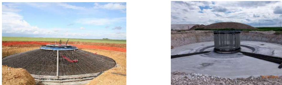
Figure 168 : Exemples de ferrailage et coulage des fondations
