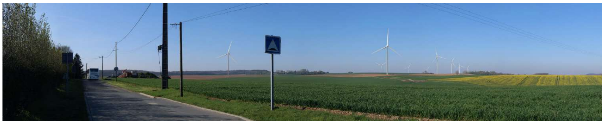
Figure 247 : Vue du parc éolien des Fortes Terres depuis la sortie sud de La Vallée Mulâtre par la D 68
