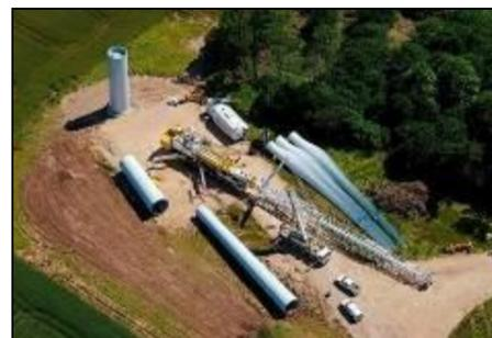
Photo 18 : Vue d'ensemble des étapes d'assemblage de la tour (exemple de tour en acier)
