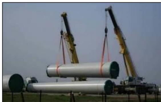
Photo 16 : Manipulation des tronçons d'éoliennes
