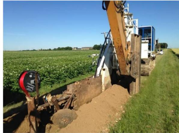
Illustration 3 : Engin utilisé pour le creusement de la tranchée et la pose des câbles
