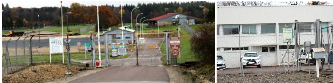
Photo 37 : Dépôt d'hydrocarbures et centre de maintenance de Gennes de la société du pipeline sud-européen
