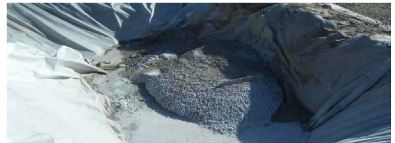
Photo 17 : Protection par géotextile pour le nettoyage des goulottes des camions toupie)
