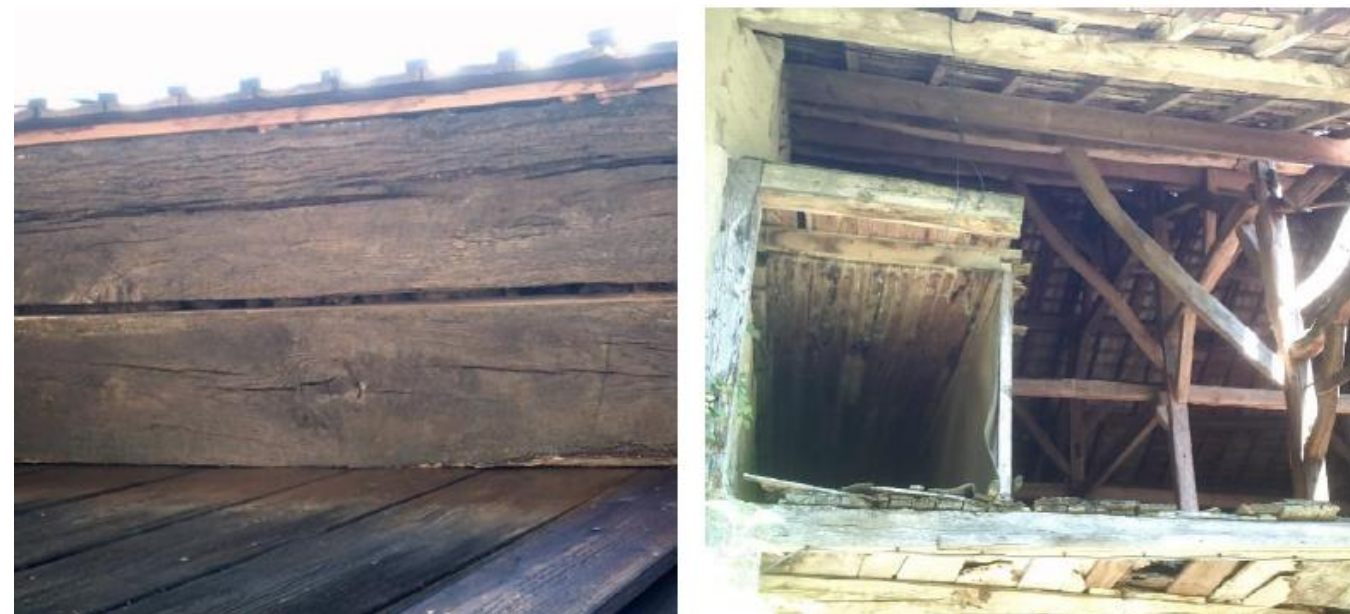
Photo 24 : La Chevillotte présente plusieurs fermes et granges favorables aux chiroptères avec des doubles poutres (à gauche) ainsi que des combles accessibles (à droite). (Source : C.FERREIRA)
