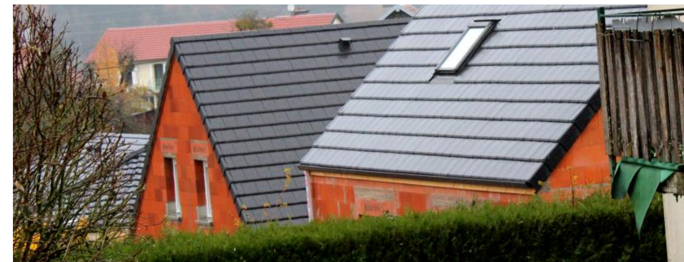
Photo 36 : Exemple de maisons en construction dans le bourg de Nancray
