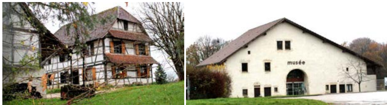
Figure 224 : Exemple de bâtiments du musée des Maisons Comtoises à Nancray
