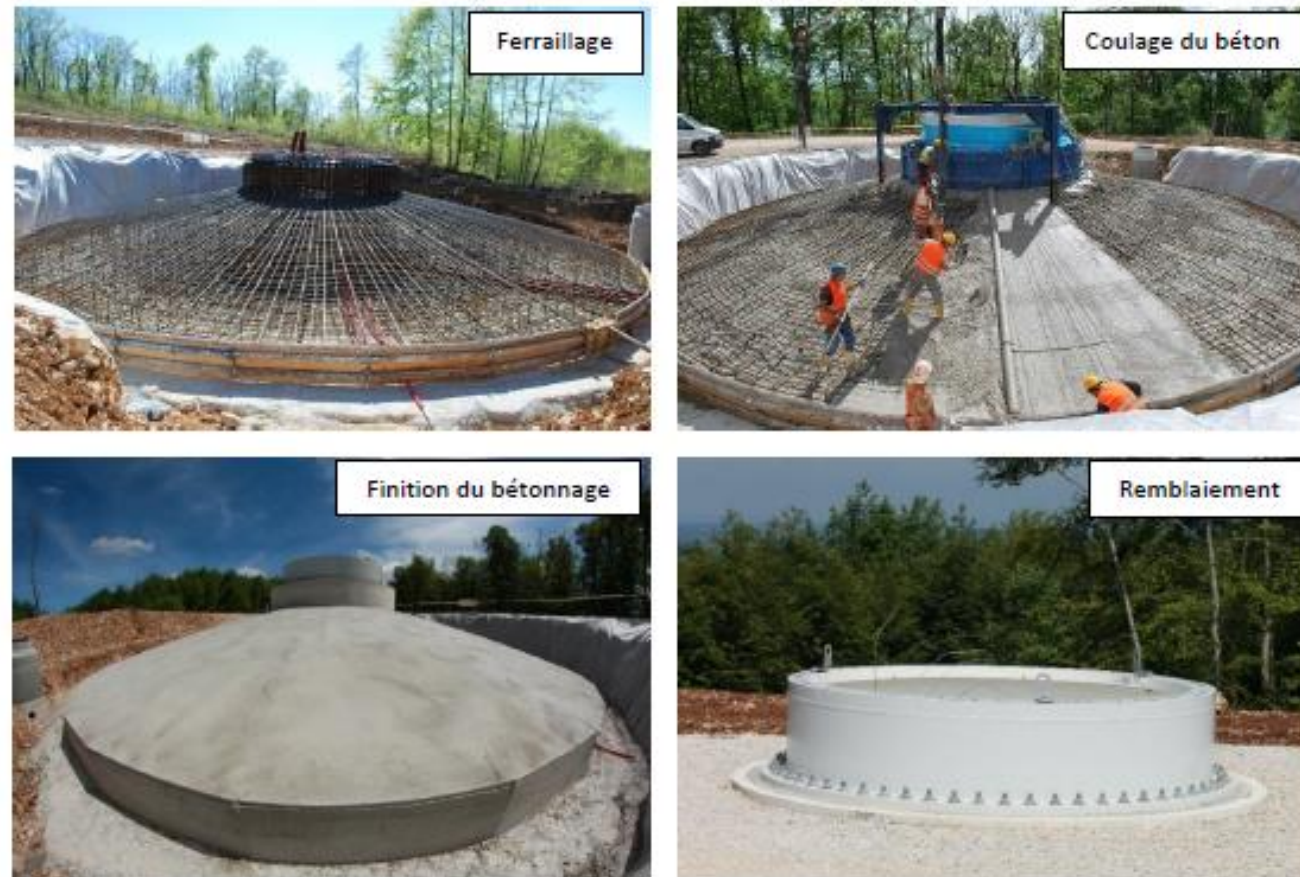
Photo 5 : Illustration d'une fondation (Opale)
