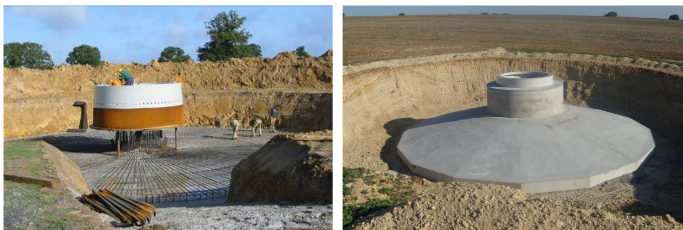
Photo 2 : Le ferrailage et le coulage d'une fondation d'éolienne
