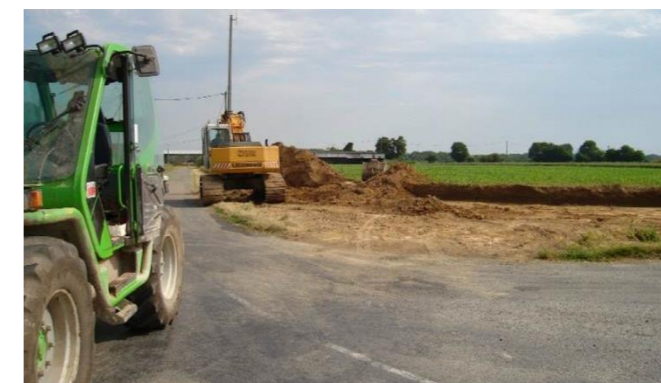
Photo 116 : les travaux de rectification d'un virage
