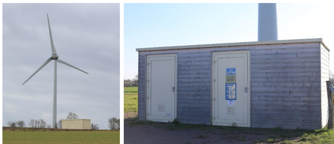
Photo 110 : exemples de poste de livraison électrique
