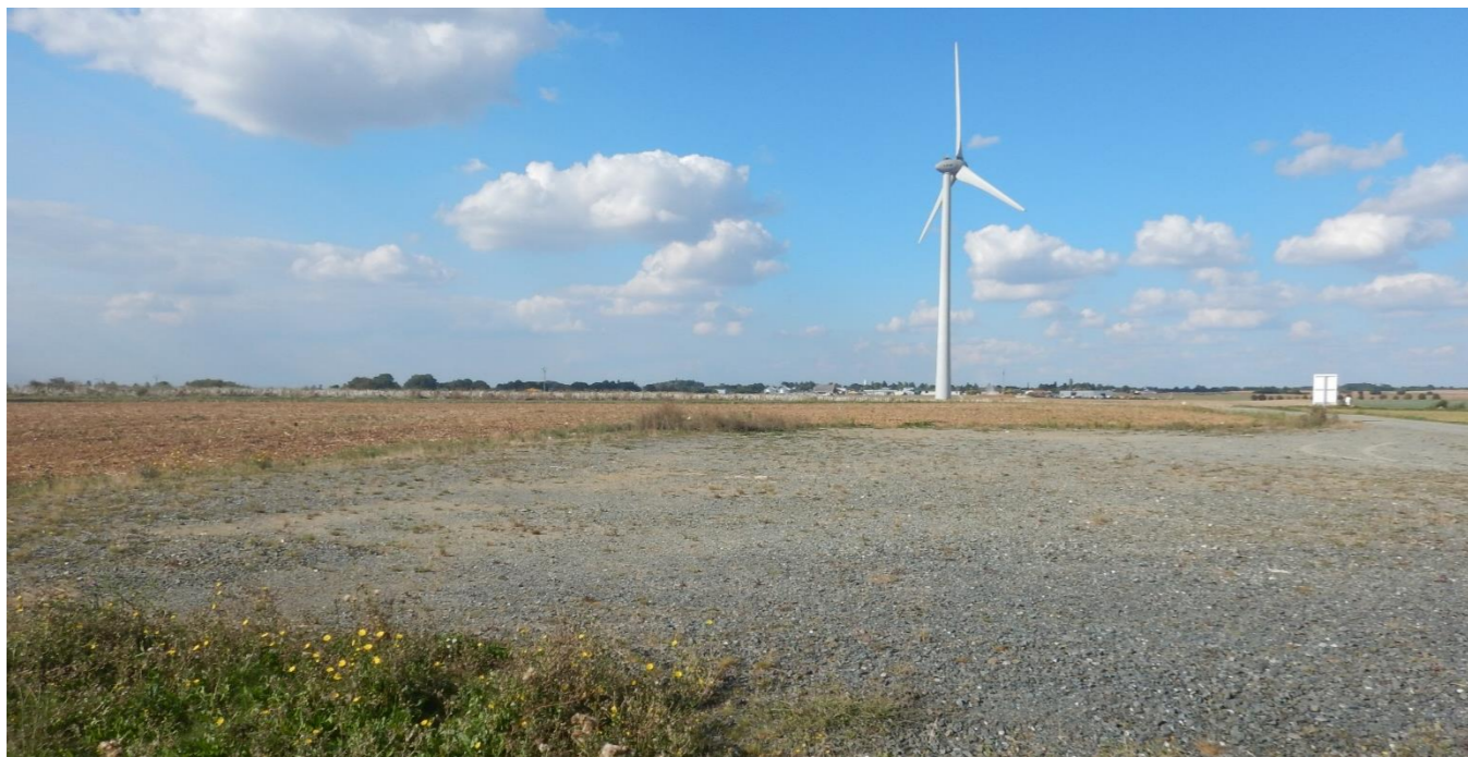
Photo 108 : un exemple d'aire de grutage depuis le pied d'une éolienne
