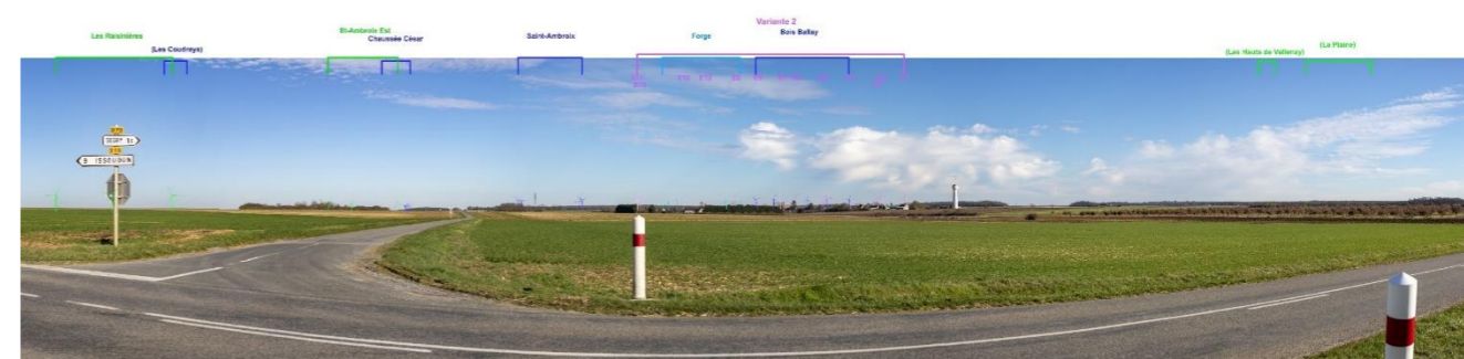
Figure 62 : La variante 2 vue depuis le point de photomontage n°32 (vue schématique couleur non-gommée)
