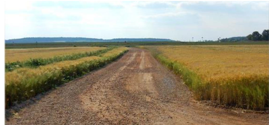
Photo 109 : un exemple de voie d'accès à un parc éolien en milieu agricole
