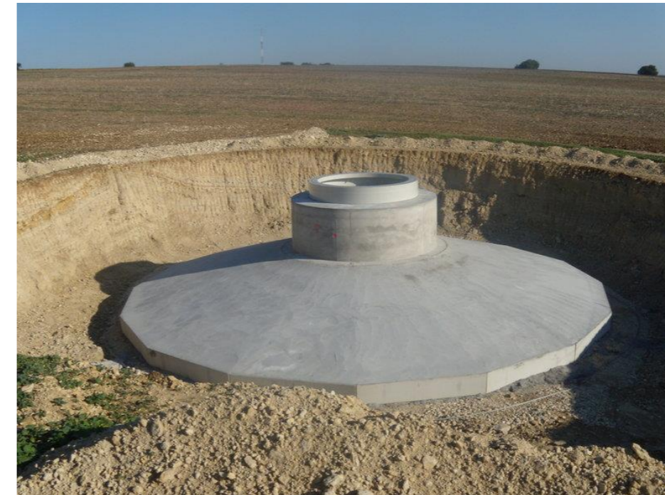
Photo 107 : Le coulage d'une fondation d'éolienne
