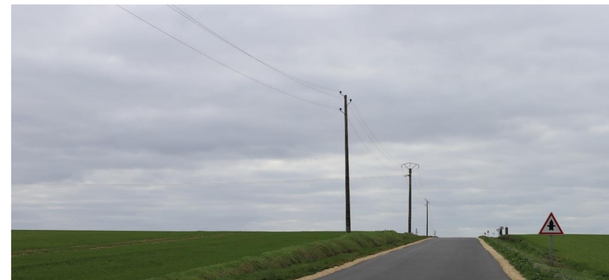
Photo 10 : Le réseau d'électricité qui suit le tracé de la RD 18 (source : AEPE Gingko)
