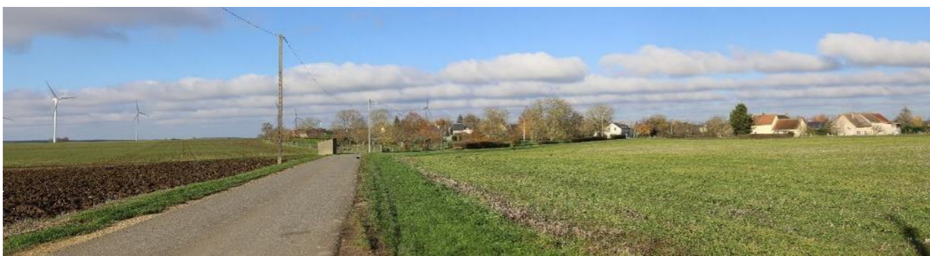
Photo 63 : Le motif éolien est largement perceptible depuis les hameaux comme aux hameaux du Grand Semur et de Villiers – la zone de projet s'étend à l'arrière des bâtiments.
