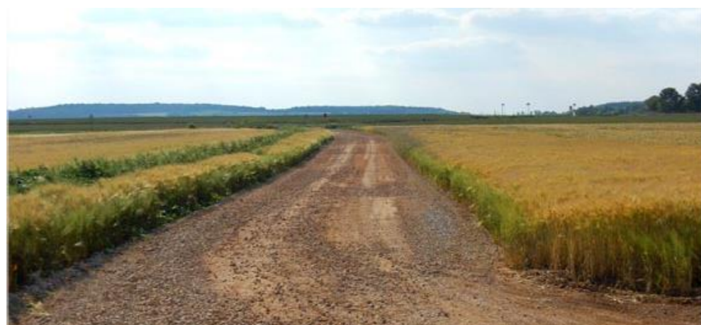
Photo 4 : un exemple de voie d'accès à un parc éolien
