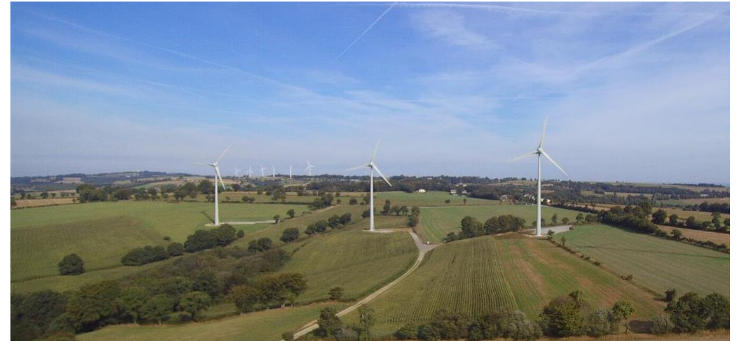
Photo 1 : un parc éolien en exploitation (AEPE gingko)
