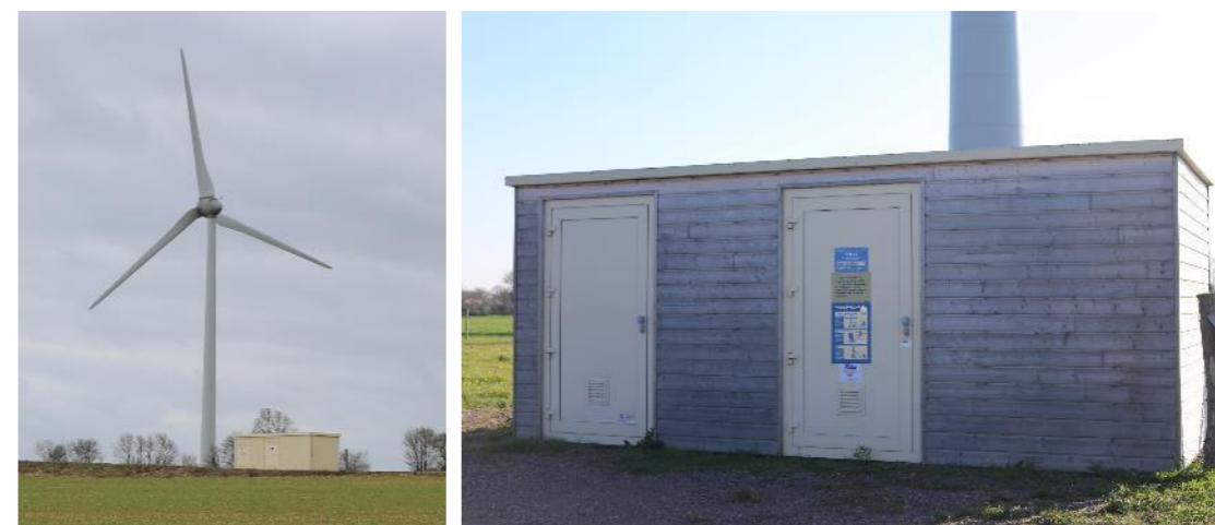
Photo 5 : exemples de poste de livraison électrique
