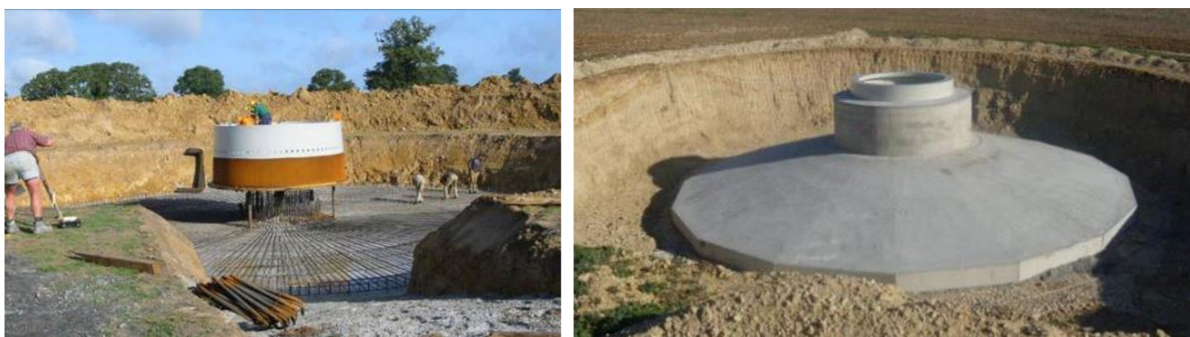
Photo 3 : le ferrailage et le coulage d'une fondation d'éolienne
