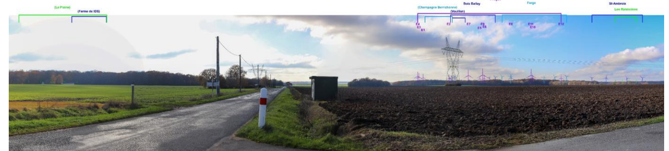
Figure 26 : La variante 3 [retenue] vue depuis le point de photomontage n°27 (vue schématique couleur non-gommée)
