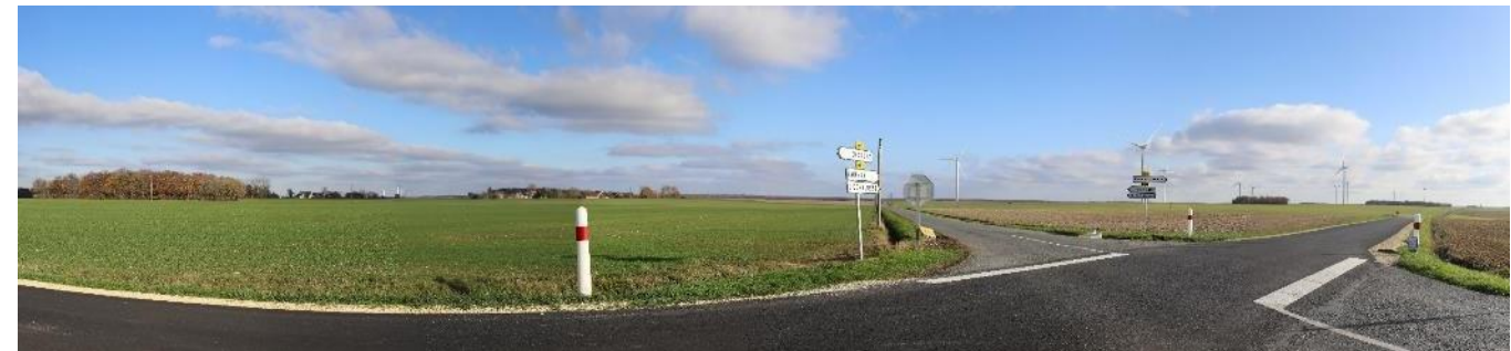
Photo 59 : La RD18 traverse la zone de projet – ses abords sont dégagés et le regard porte loin.
