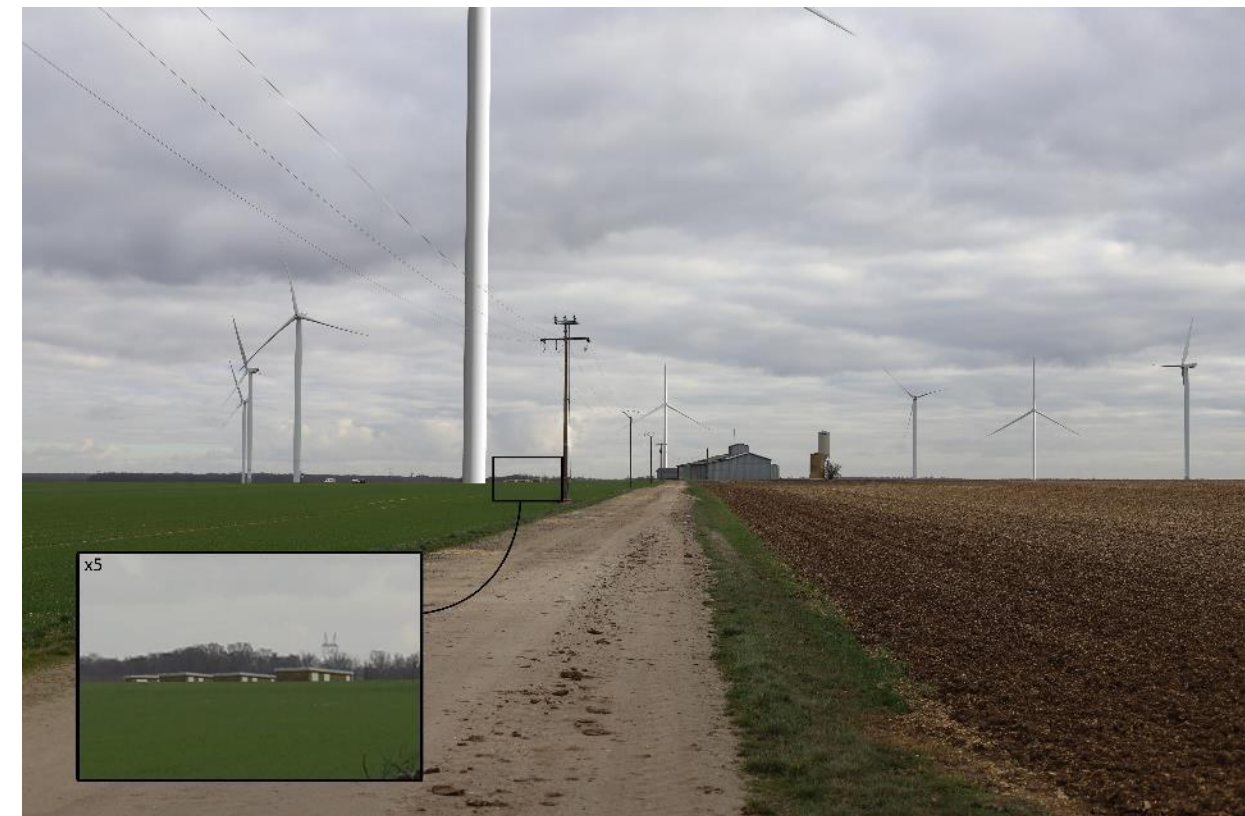
Photo 98 : Photomontage des postes de livraison depuis l'intersection entre la RD18 et le chemin d'accès menant à E10 et aux postes de livraisons
