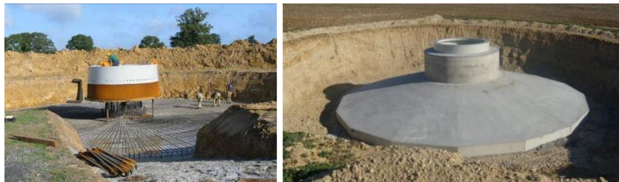
Figure 3 : le ferrailage et le coulage d'une fondation d'éolienne
