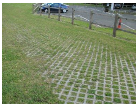
Exemple de revêtement perméable et carrossable
