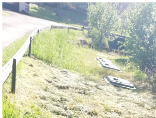
Glissière de sécurité entre la route et la STEP
