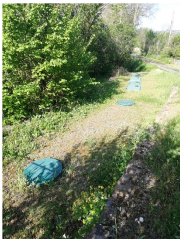
Fosses au 1 er plan et filtres à coco au 2 nd plan
