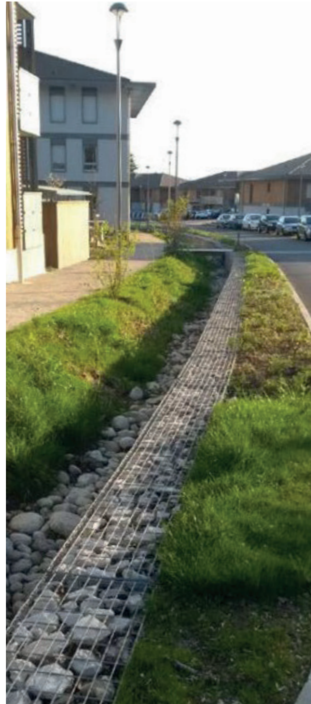
Exemple de tranchée infiltrante
