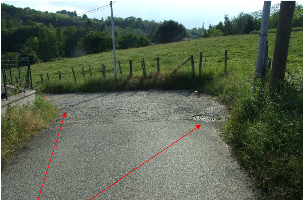
Caniveau grille et grille avaloir en travers, au débouché de la combe sur le chemin d'Ortis
