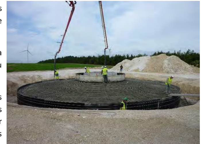
Photo 1. Construction d'une fondation
