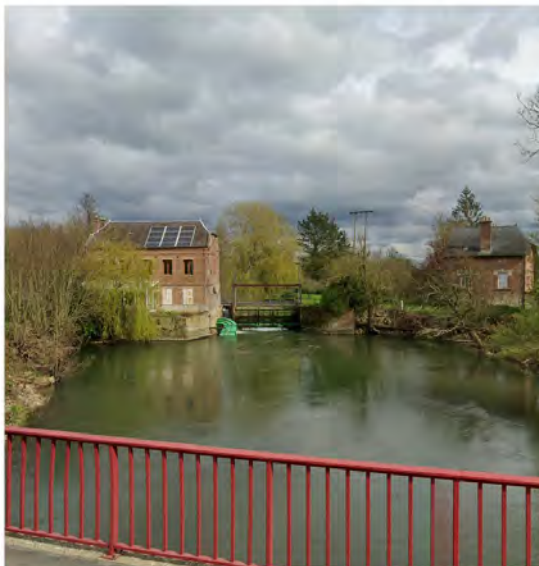
NP2 - Moulin à eau de Tavaux-et-Pontséricourt
