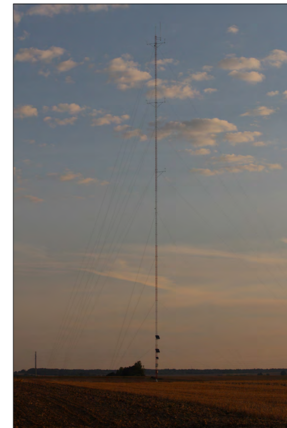
Photo 28 : Vue sur le mât de mesures
