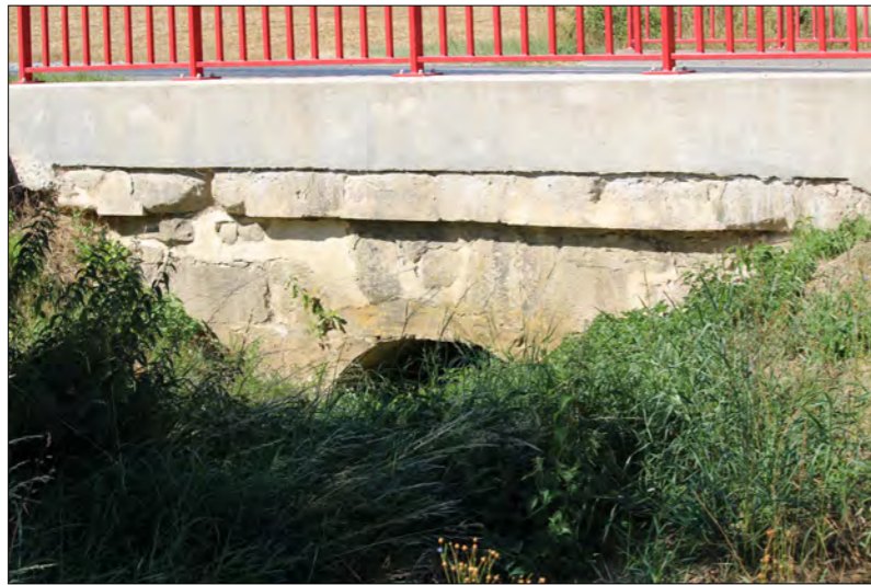
Photo 29 : Vue sur l'ouvrage d'art situé sous la RD 25
