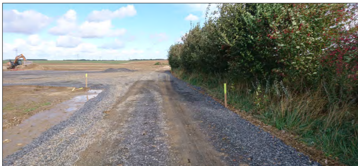
Photo 39 : Exemple de création de chemin d'accès
