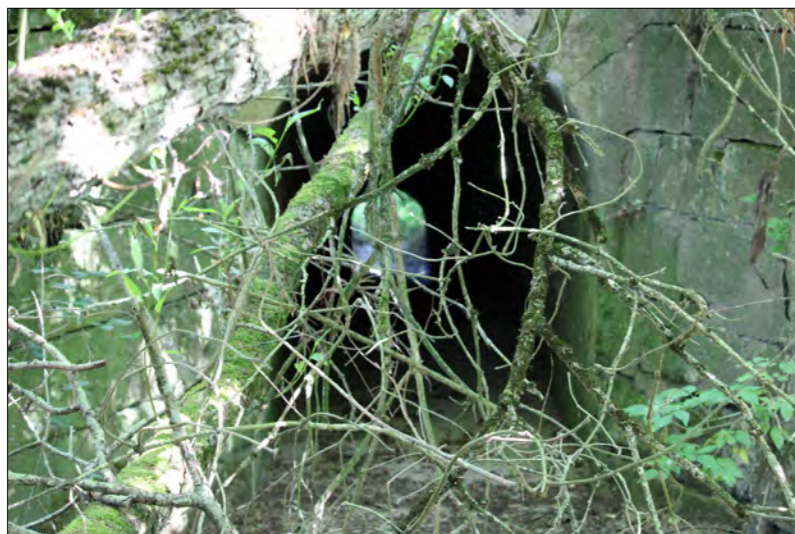
Photo 30 : Vue sur l'ouvrage d'art situé sous la RD 946
