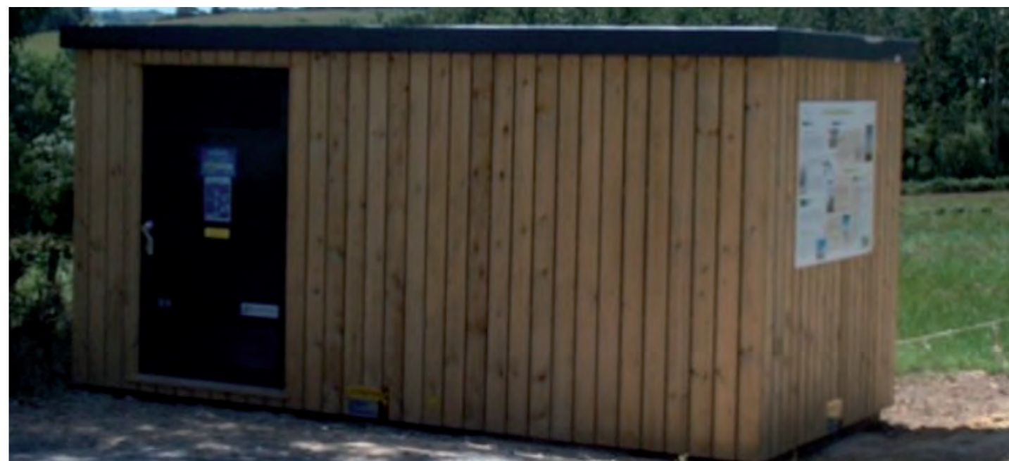
Poste de livraison envisagé
