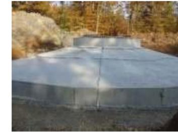
Massif d'éolienne avec ceinture équipotentielle pour MALT
