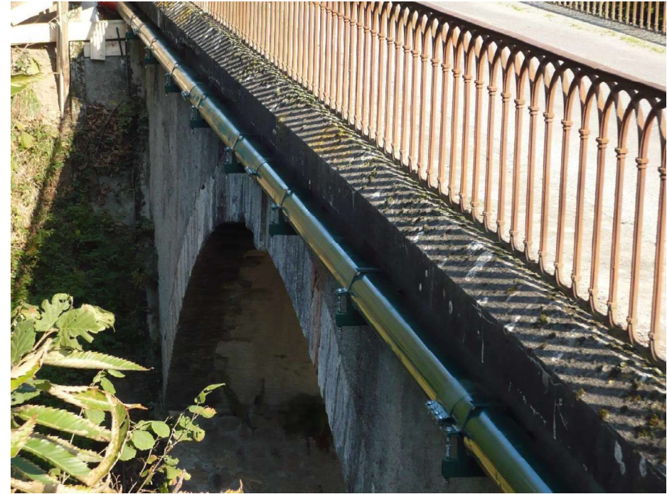
Figure 7: Exemple d'encorbellement au niveau d'un pont
