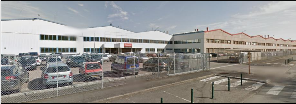
Photo 25.: Les bâtiments d'activité depuis la rue Jean Monnet en 2013 (source : google streetview)
