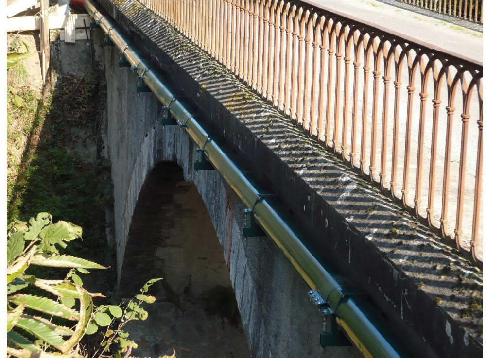
Figure 43: Exemple d'encorbellement au niveau d'un pont
