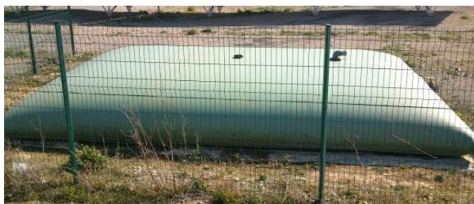
Figure 42: Exemple de citerne souple : bâche incendie
