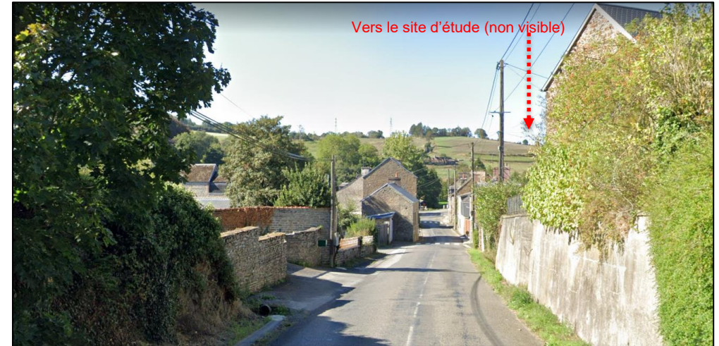
Photo 18: Vue 11 : depuis pont Erembourg, le versant du vallon formé par La Vère ferme les vues lointaines
