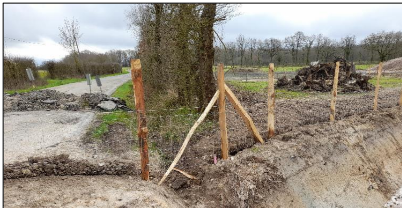
Figure 49: Illustration de mise en défens en phase chantier
