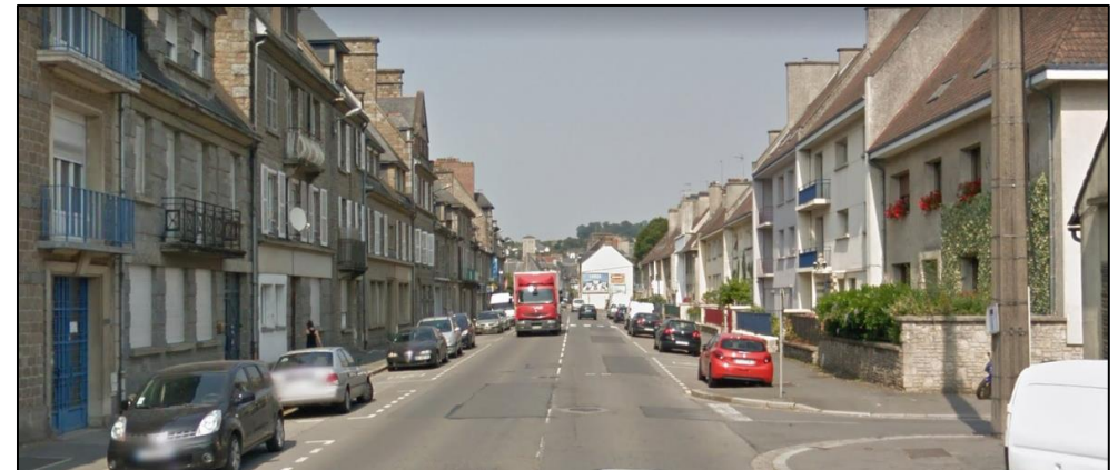
Photo 13: Vue 6 : depuis la RD 562 dans le tissu urbain de Condé (source : google streetview)
