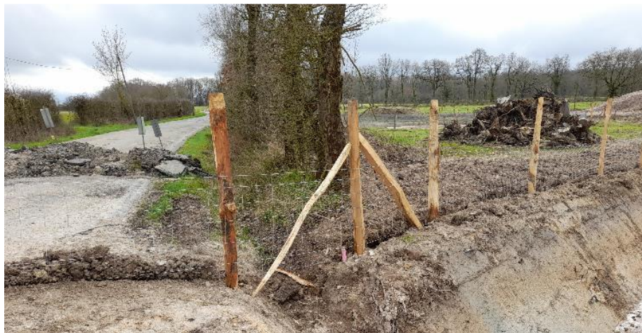
Figure 48: illustration d'une mise en défens en phase chantier
