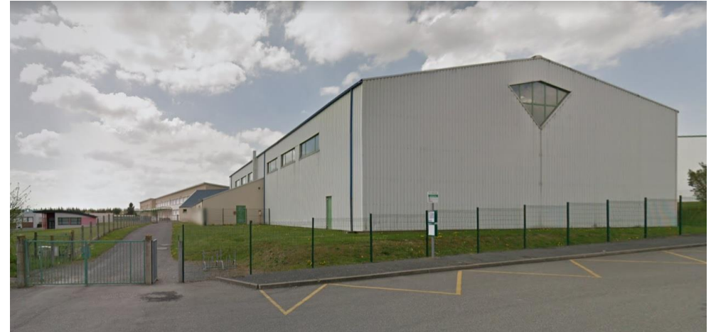
Figure 7. Le gymnase Charles Tellier dans la zone industrielle le Haut Mesnil
