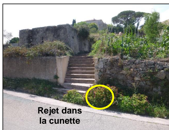
Photo 1 : Regard-grille et conduite sous l'escalier avec rejet dans la cunette en bord de RD413 (TPAe, le 27/08/2019)
