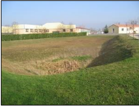
Photo 6 : Bassin de rétention en forme de noue
