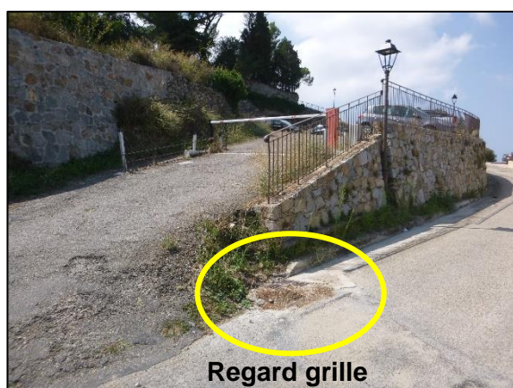
Photo 1 : Regard-grille et conduite sous l'escalier avec rejet dans la cunette en bord de RD413 (TPAe, le 27/08/2019)
