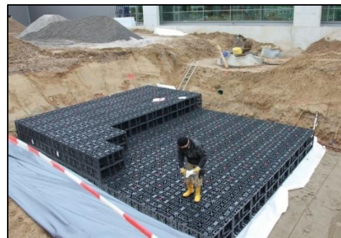
Photo 8 : Mise en place d'un bassin enterré à structure alvéolaire
