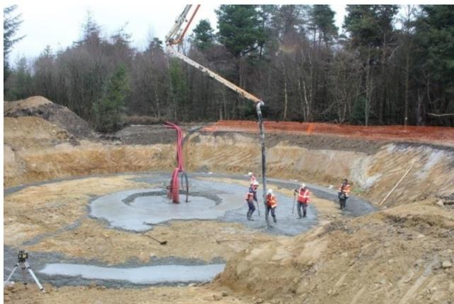
Les fondations sont des semelles circulaires d'environ 10m de rayon (20m de diamètre) Elles s'enfoncent de plusieurs mètres dans le sol.
