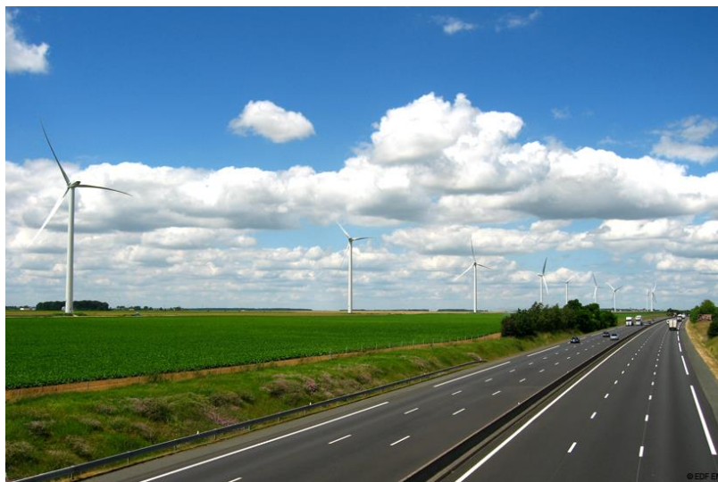
Figure 14 : Parc éolien du Chemin d'Ablis dans l'Eure et Loir : 26 éoliennes, 52 MW
