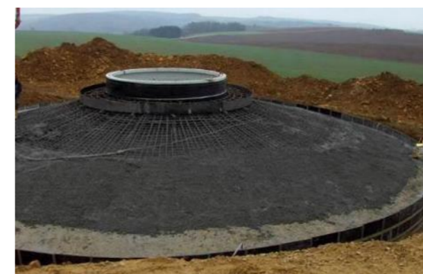
Figure 16 : Exemple de ferrailage en radier pour une éolienne
