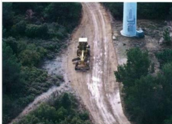
1 - Début des travaux et préparation des accès
