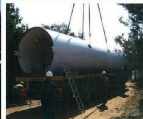
6 - Retournement avec la grue secondaire avec préparation et mise en place sur les camions navettes
