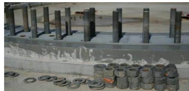
Figure 18 : Détail des fixations de la fondation
