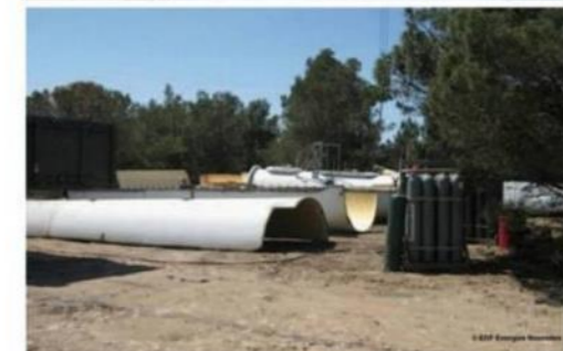
7 - Déchargement et découpe au chalumeau sur la plateforme de découpe avec mise au format pour évacuation vers les filières de gestion des déchets
