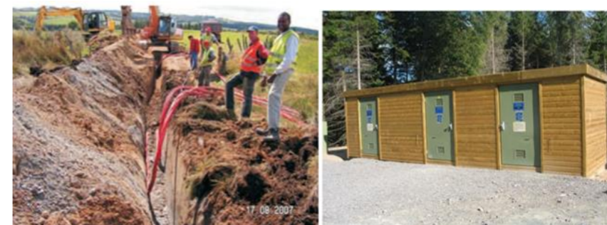
Photographie 7 : Déroulage et pose des câbles (à gauche), poste de livraison (à droite) (Source : EDF Renouvelables)
