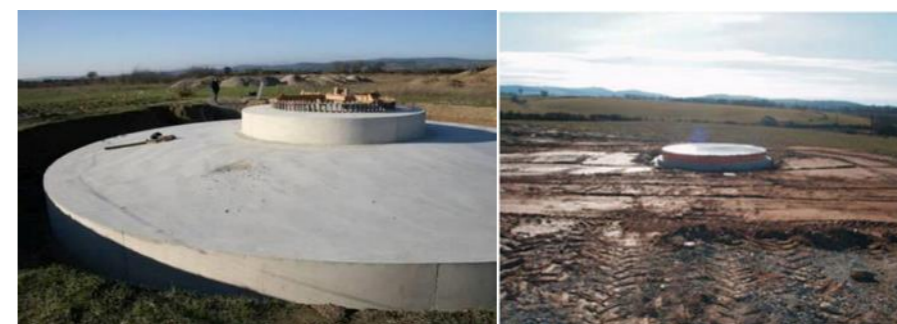
Photographie 4 : Massif béton terminé (à gauche), état final après remblaiement (à droite) (Source : EDF Renouvelables)
