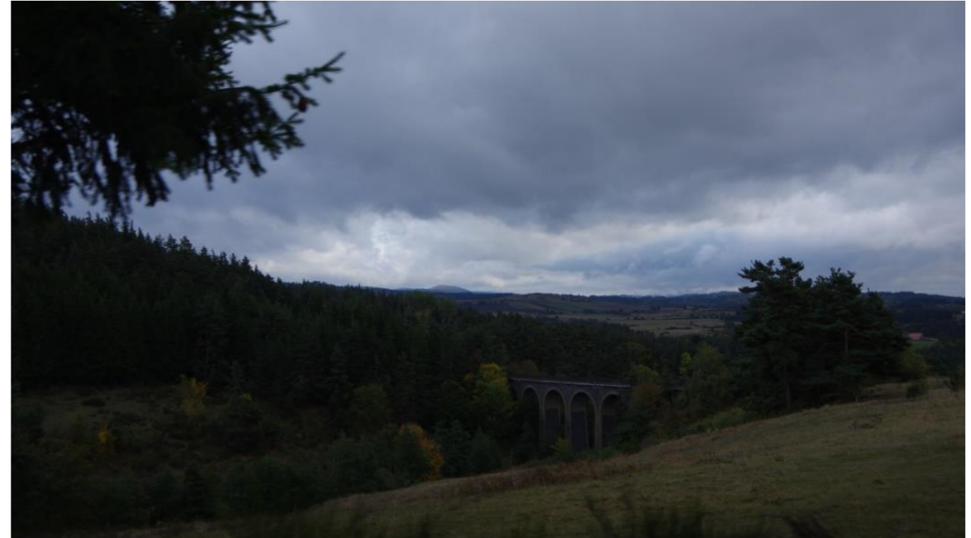
Photographie 166 : Passage du vélorail sur un ancien ouvrage
