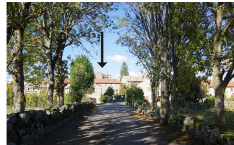
Photographie 127 : Château de Condres - depuis l'entrée Sud du bourg
