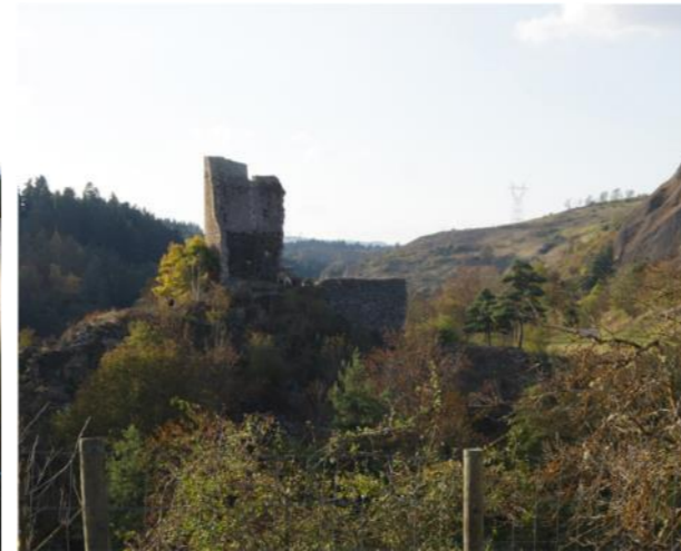
Photographie 146 : Château de Jonchères - depuis la D401
