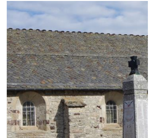
Photographie 104 : Toiture en Lauzes
