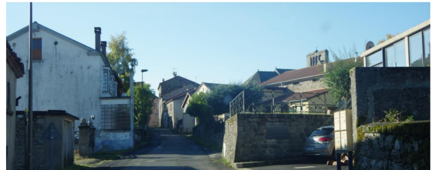
Photographie 158 : Rue principale de Lespéron : vue vers le Sud
