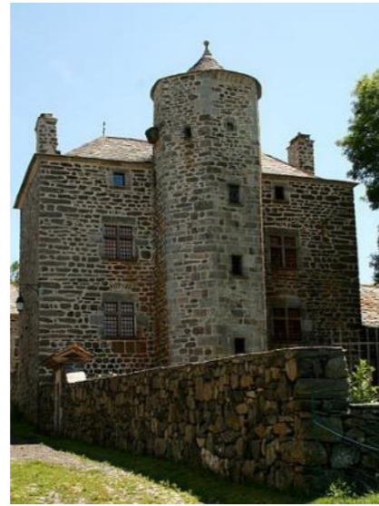
Photographie 129 : Maison forte à Freycenet-la-Cuche - Source : https://monumentum.fr
