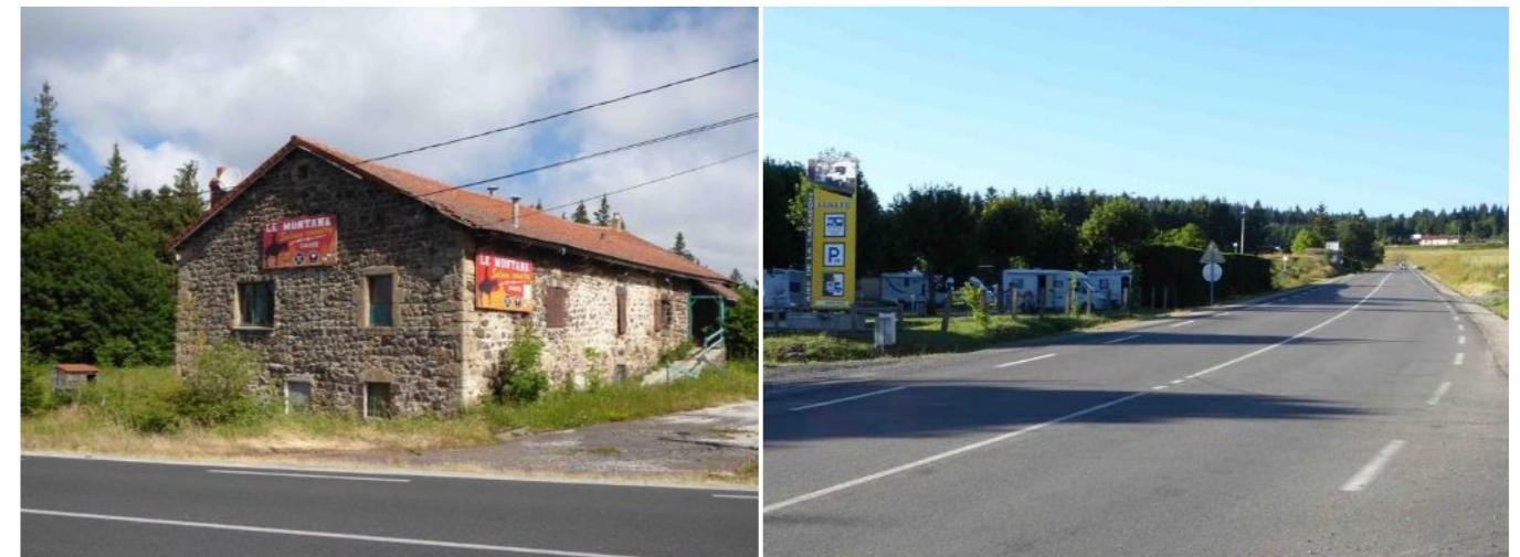
Ancien snack-bar "Le Montana" abandonné au col de la Fayette (à gauche) et aire de camping-car à l'entrée nord du bourg de Pradelles (ZIP en arrière-plan, en ligne de crête).
