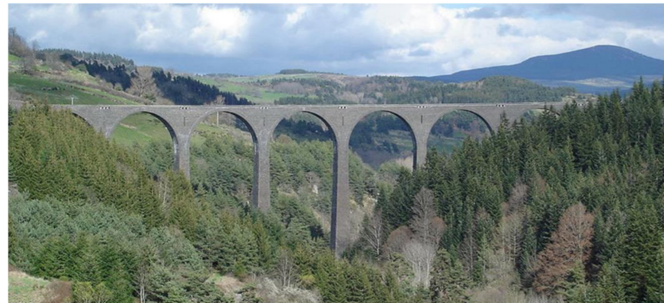
Photographie 133 : Viaduc de la Recoumène à Le Monastier-sur-Gazeille - Source : https://monumentum.fr
