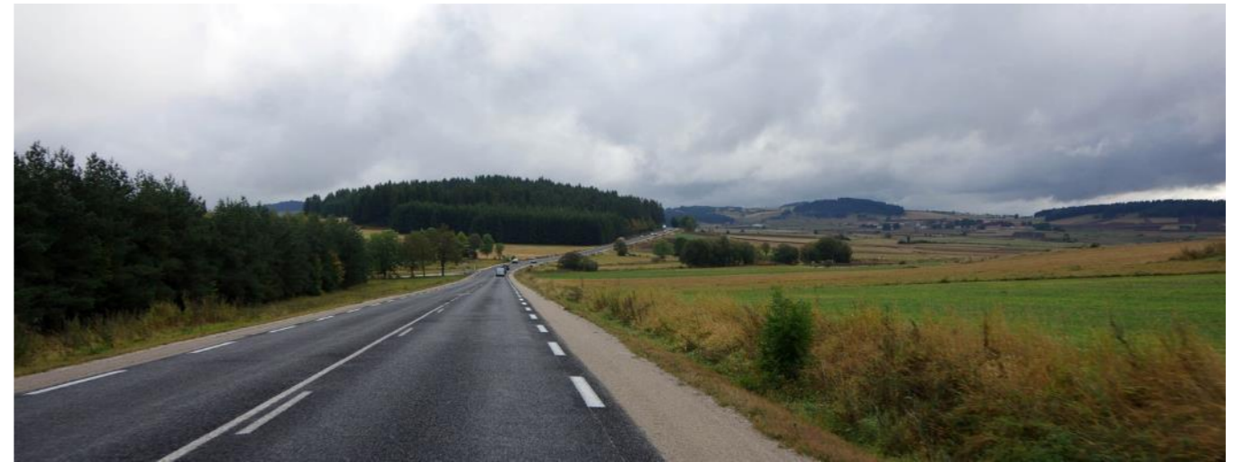
Photographie 108 : N88 en direction de la ZIP, depuis l'intersection avec la D531 à hauteur de Barges
