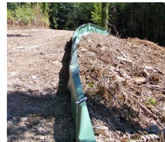
Photographie 5 : Exemple de bâche installée dans le cadre d'un chantier (source : CERA)
