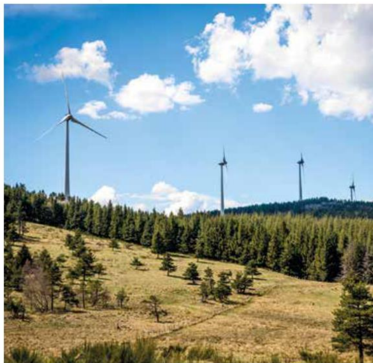
Parc éolien de la Montagne ardéchoise
