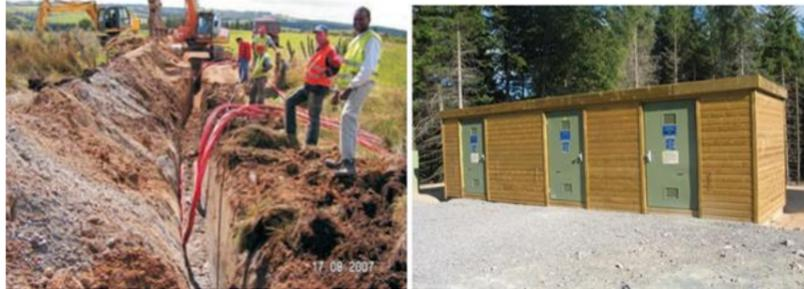
Photographie 7 : Déroutage et pose des câbles (à gauche), poste de livraison (à droite) (Source : EDF Renouvelables)
