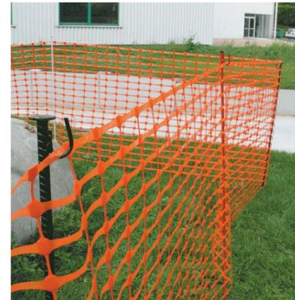
Figure 111 : Dispositif de mise en défens
