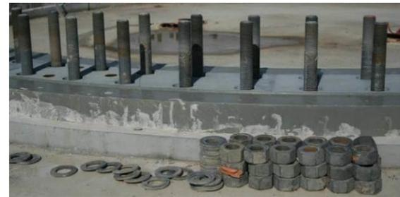
Figure 12 : Détail des fixations de la fondation
