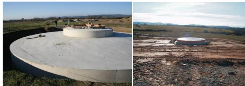
Photographie 4 : Massif béton terminé (à gauche), état final après remblaiement (à droite) (Source : EDF Renouvelables)
