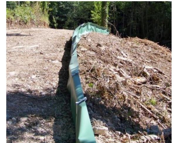
Cette bâche de soixante-dix centimètres de haut sera plaquée et brochée au sol sur une longueur de trente centimètres et sera posée de sorte à créer un rabat sur le haut du filet (photo ci-contre). La clôture aura les caractéristiques suivantes :
