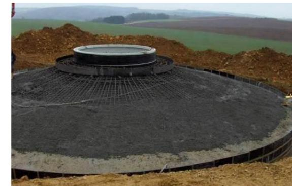
Figure 10 : Exemple de ferrailage en radier pour une éolienne
