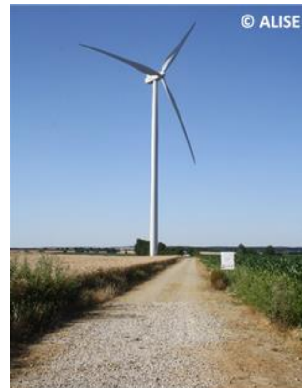
Photo 2 : Exemple de piste d'accès à une éolienne
