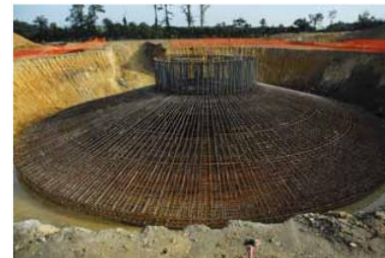
Photo 3 : Construction de l'armature d'une fondation
