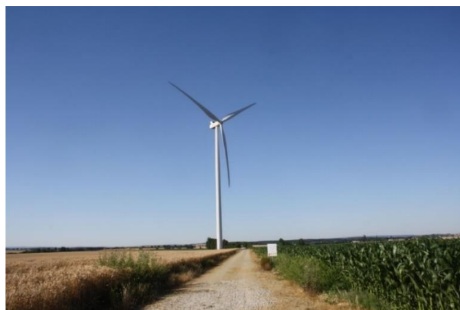
Photo 8 : Piste d'accès d'une éolienne
