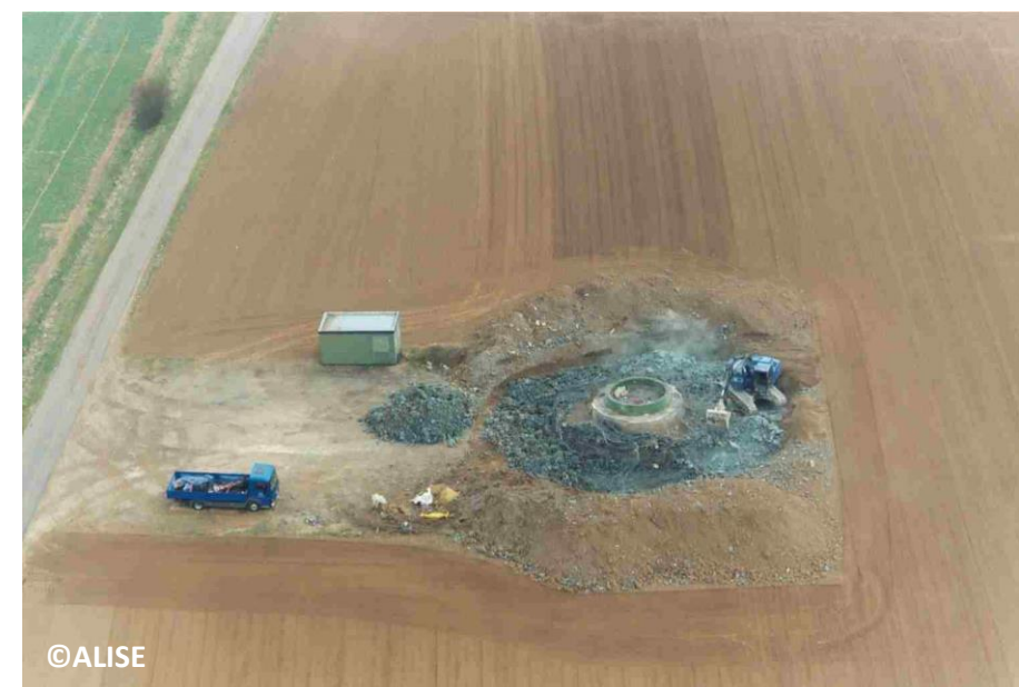
Photo 4 : Exemple de démontage de la plateforme et des fondations d'une éolienne
