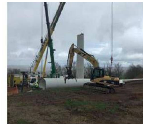
Photo 5 : Démontage d'un mât
