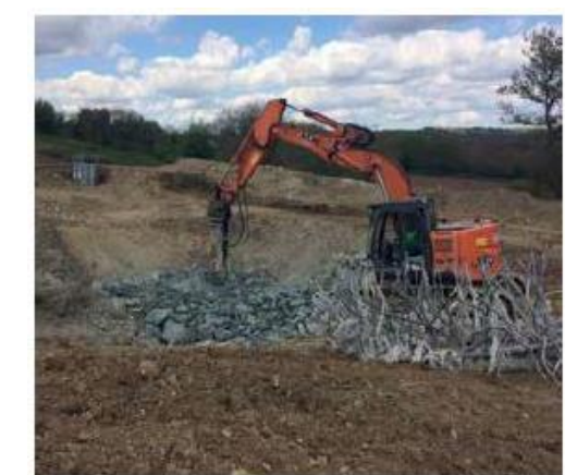
Photo 6 : Démolition de la fondation
