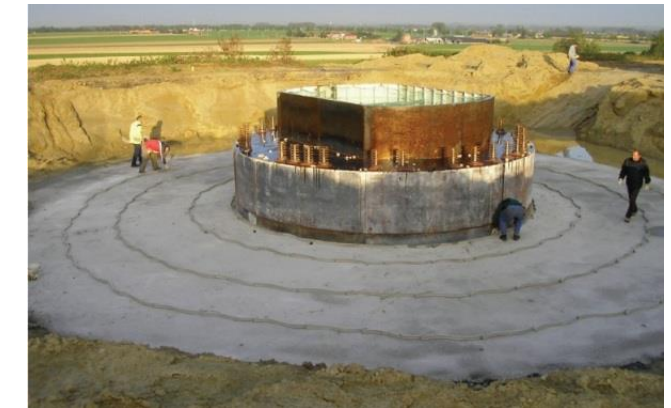
Photo 2 : Durcissement béton
