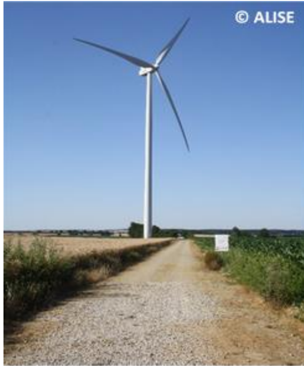
Photo 7 : Exemple de piste d'accès aux éoliennes
