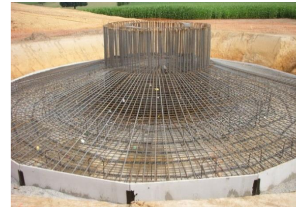
Photo 1 : Excavation et préparation de l'armature
