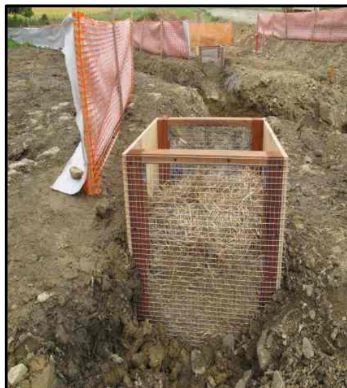
Dispositif de filtration sur végétaux dans cadre préfabriqué
