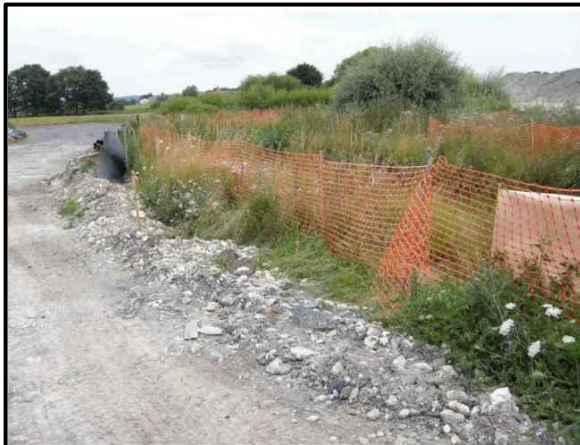
Création de merlons de protection
