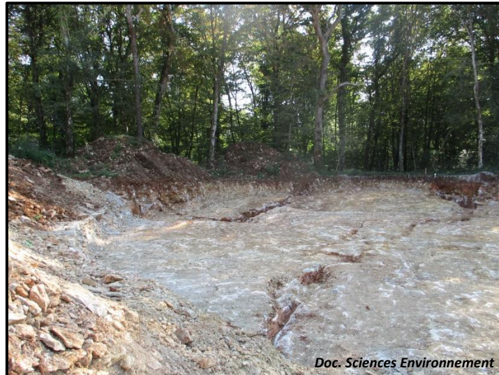
Exemple d'anomalie pouvant être traitée directement en fond de fouille
