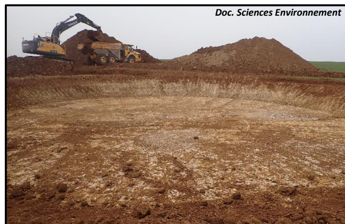
Mise à nu des bancs calcaires sous la couverture épikarstique
