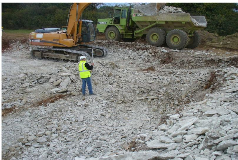
Voici les fouilles obtenues (terrassements terminés), avant coulage du béton de propreté
