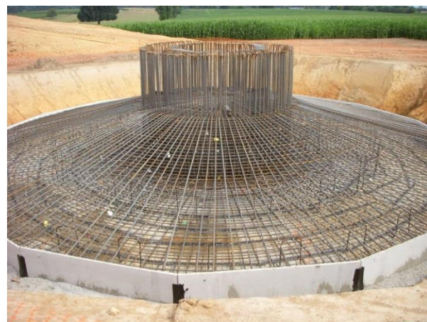
Photo 2 : Construction de l'armature d'une fondation
