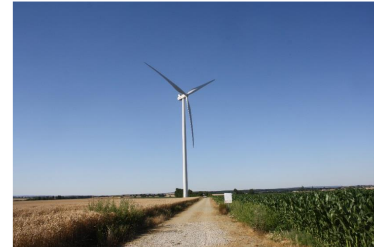
Photo 1 : Exemple de piste d'accès aux éoliennes
