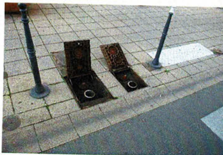
Illustration n°7 : Photographies d'un Poteau incendie et de Deux Bouches Incendie.
