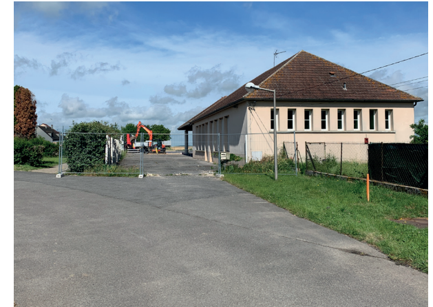
ÉCOLE (AVANT TRAVAUX D'EXTENSION)
