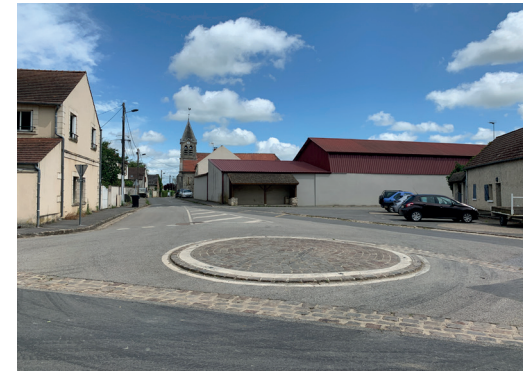
MANQUE DE MISE EN VALEUR DE L'ÉGLISE ET DE L'ESPACE PUBLIC OÙ SE RENCONTRENT LES RUES ANCIENNES
