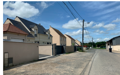
FERMETURE DE L'ESPACE PUBLIC PAR LA PRÉSENCE DES MÛRS DE CLÔTURE
