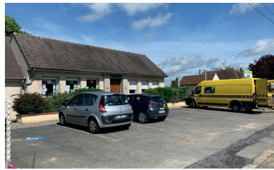
PARVIS DE LA MAIRIE AVANT TRAVAUX
