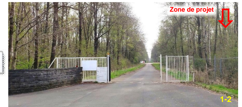
Photo 13 : Portail d'accès à la zone de projet par l'Ouest depuis la RD32 (Source : Néodyme)
