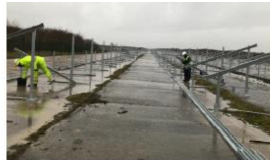
Pose des postes (à gauche) et mise en place des structures (à droite) (source : CVE)
