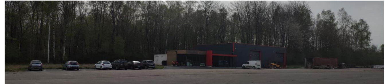
Photo 10 : Bâtiment Acacia (source : Néodyme)
