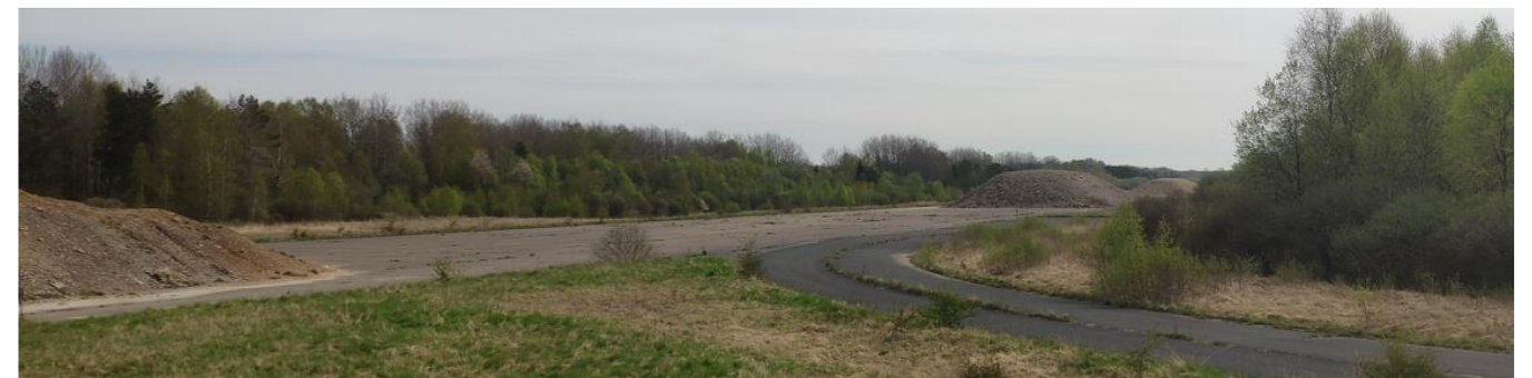
Photo 2 : Planéité au droit des parcelles d'implantation et talus de déblais sur la piste Nord (source : Néodyme)
