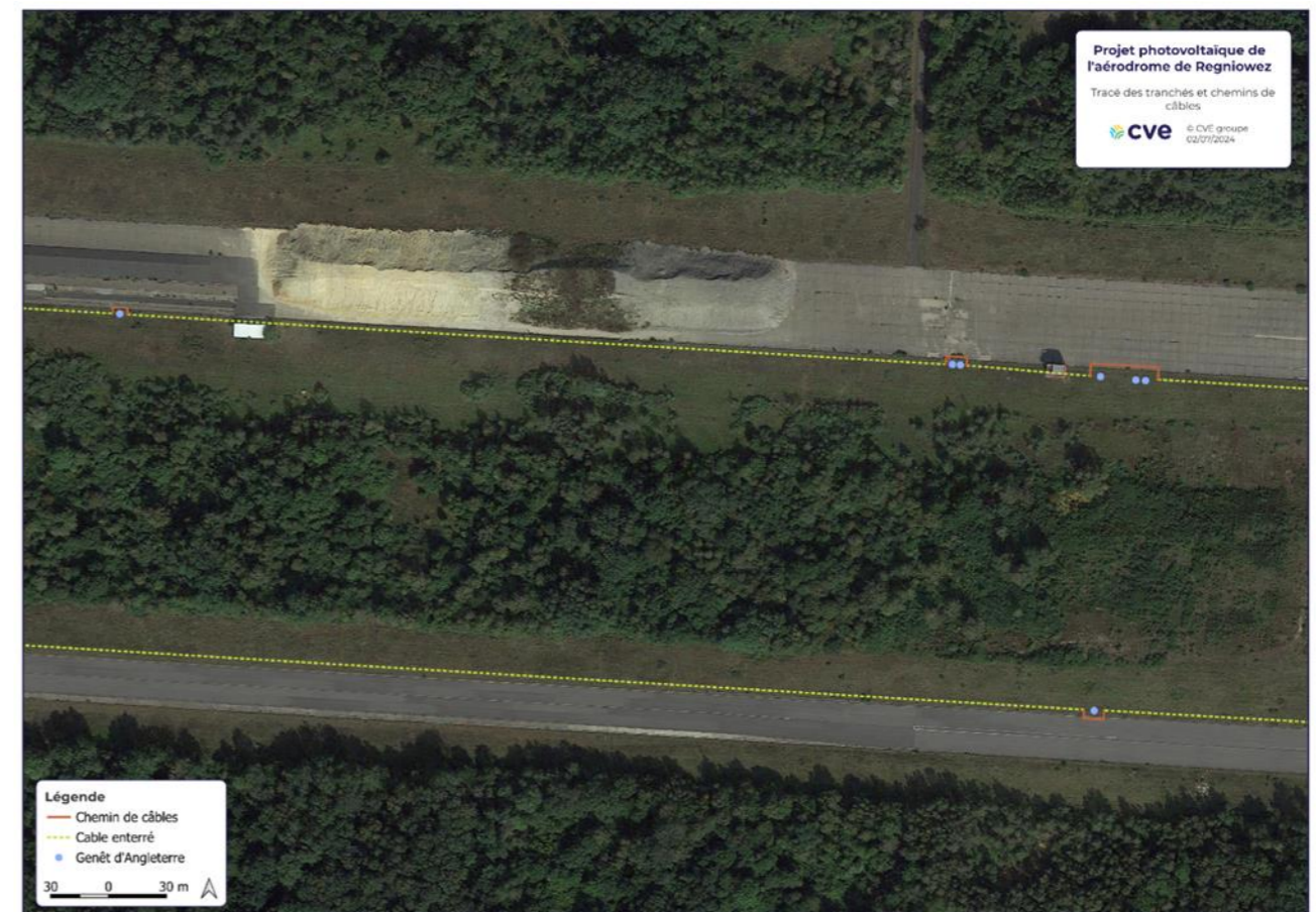
Carte 59 : Exemple de tracé des tranchées et des chemins de câbles (source : CVE)
