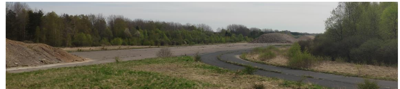
Planéité au droit des parcelles d'implantation et talus de déblais sur la piste Nord (source : Néodyme)
