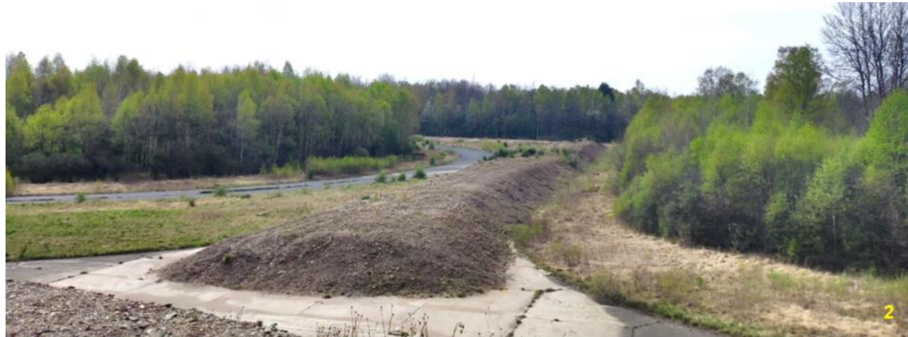
Vue depuis le merlon à l'Ouest vers la « le rond-point » au centre-Ouest (source : Néodyme)
