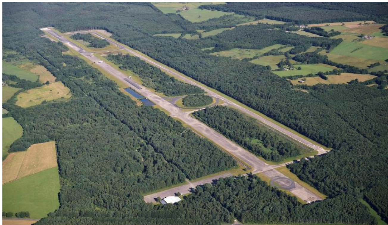
Vue aérienne de la zone d'implantation potentielle (source : CVE)
