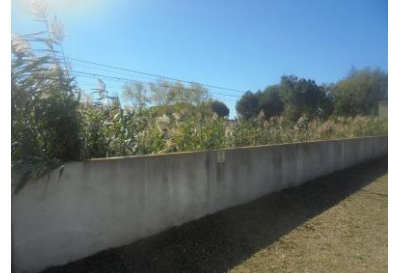
Lits de séchage des boues plantés de roseaux
