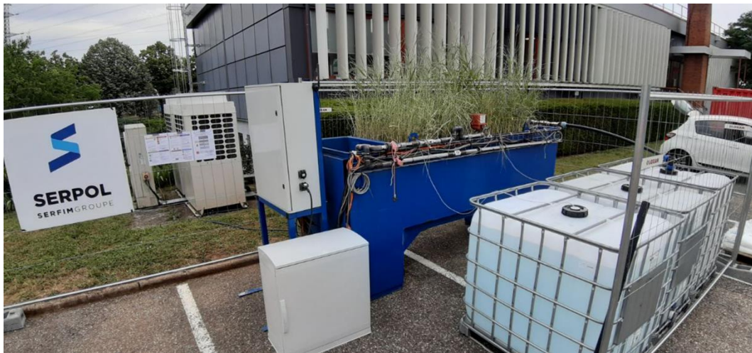
Figure 2 : Exemples d'installations pilotes : Pilote osmose inverse / nanofiltration (en haut) et pilote de filtre planté de roseaux (en bas)
