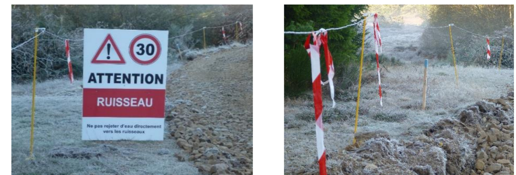
Figure 121 : Illustrations d'un balisage et d'informations sur une zone de sensibilité (Source : Synergis Environnement)
