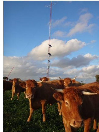
Photo 2 – Mât de mesures à Plouguenast Source : Photo Althis
