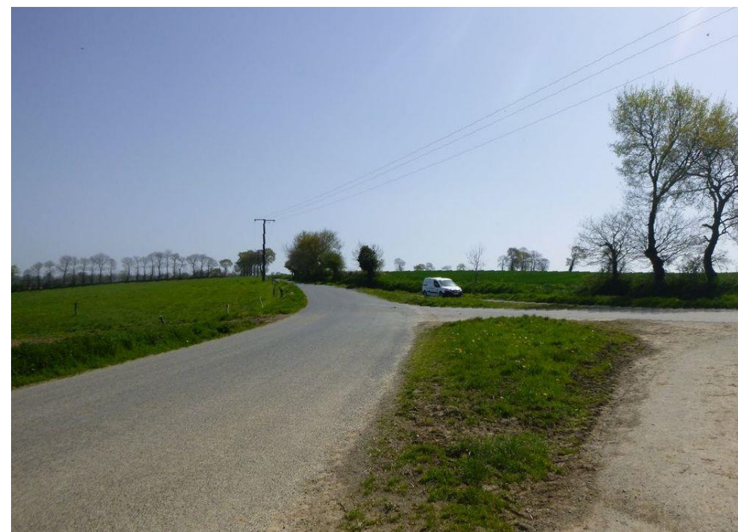
Figure 12 : RD 22 et ligne électrique HTA
