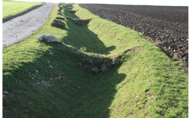
Exemple de fossé à redents en pierres sèches
