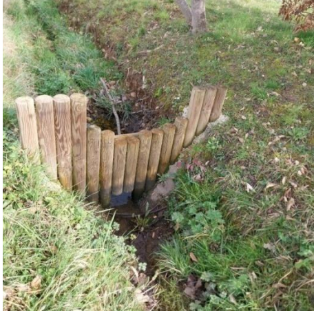
Fossé à redents en poteaux de bois, présent le long de la route du Bruissin
